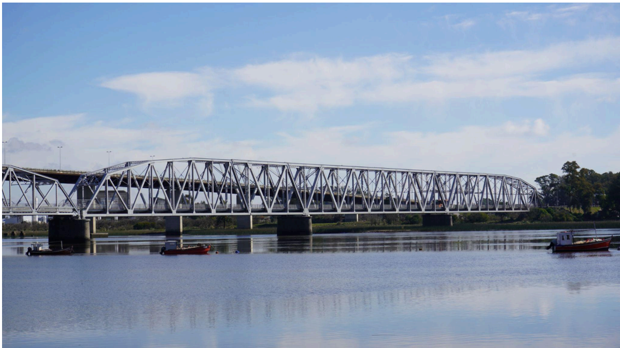
Figura 5: Puente de la Barra de Santa Lucía. Fuente: Municipio A.
